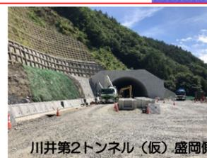
川井第2トンネル(仮)では、覆工コンクリートの施工が完了しました。現在、⑬工事でコンクリート舗装の施工を行っています。
