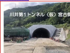
川井第1トンネル(仮)では、覆工コンクリートの施工を行っています。全長1,764mのうち1,684mまでコンクリート打設が進んでいます。
