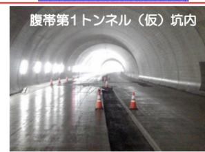
腹帯第1トンネル(仮)では、コンクリート舗装の施工を行っています。
