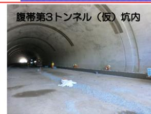
腹帯第3トンネル(仮)では、円形側溝の施工を行っています。
