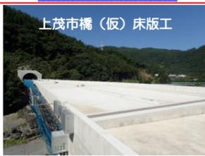
上茂市橋(仮)では、床版工の施工が完了し、足場の解体を行っています。
