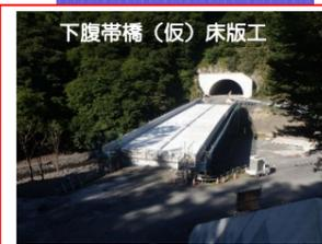
下腹帯橋(仮)では、床版工の施工が完了し、足場の解体を行っています。
